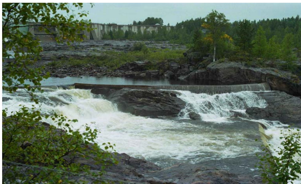
Figur 9. Området kring Laxhoppet med naturliga fall och rännor har förändrats för att förbättra passagen i gamla älvfåren under reducerade flöden. Strategiskt placerade trösklar skapar 2 eller 3 vägar för fiskpassage.
