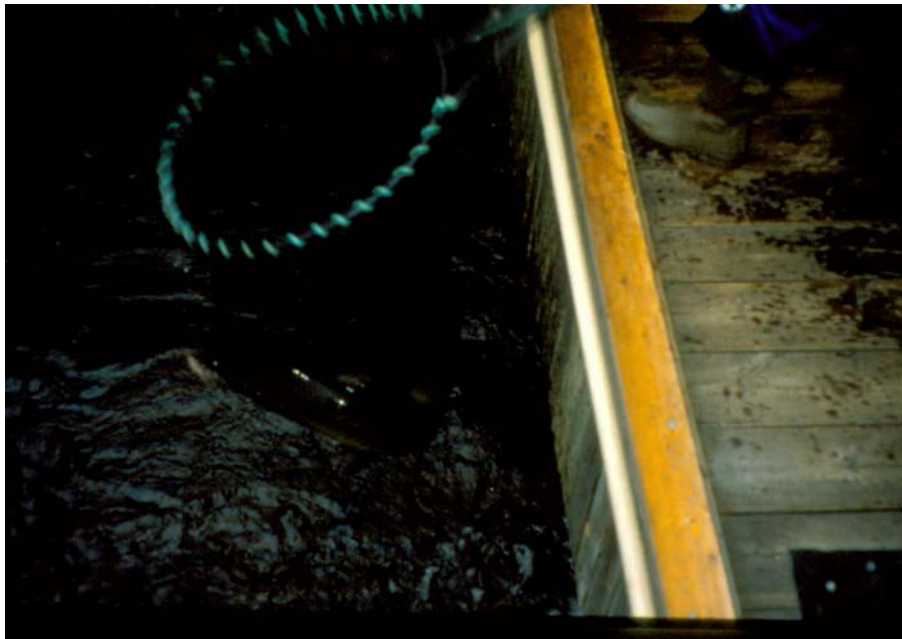
Figur 5. Fiskfällan i laxtrappans översta bassäng. Bassägen är en sk fångstbassäng med gallergolv som kan lyftas för att tränga ihop fisken innan håvning.
