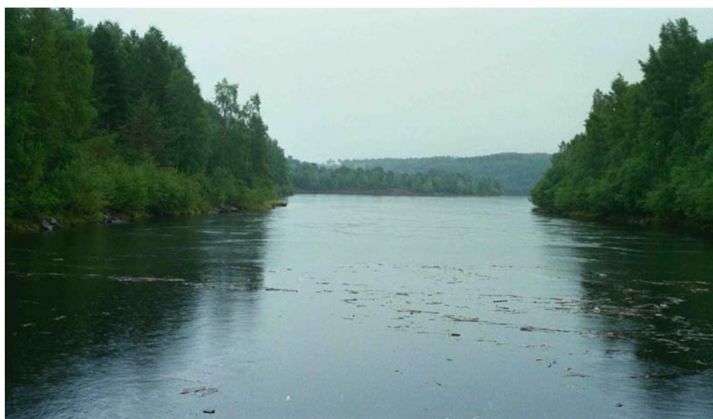
Figur 1. Utloppskanalen från Stornorrfors kraftverk, sett uppifrån (öster).
