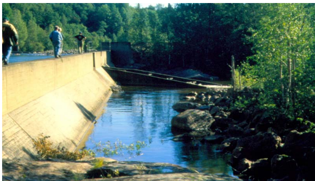
Figur 2. Liten bassäng och trappa vid den övre delen av det gamla kraftverkets inlopp.
