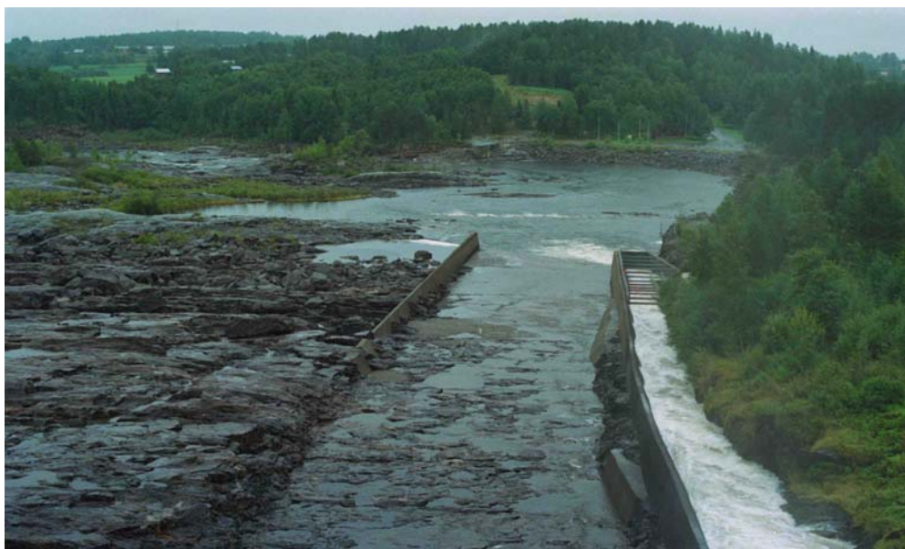
Figur 8. Utskovskanalen består av grov, obearbetad berggrund. Den första dämpningsbassängen ligger nedströms laxtrappans ingång.
