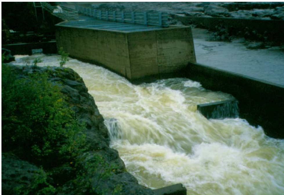
Figur 3. Ingången till Norrforsdammens laxtrappa i bildens övre vänstra del och lockvattenstillförseln till trösklarna nedtröms trappans ingång som visar det syrerika och turbulenta flödet.
