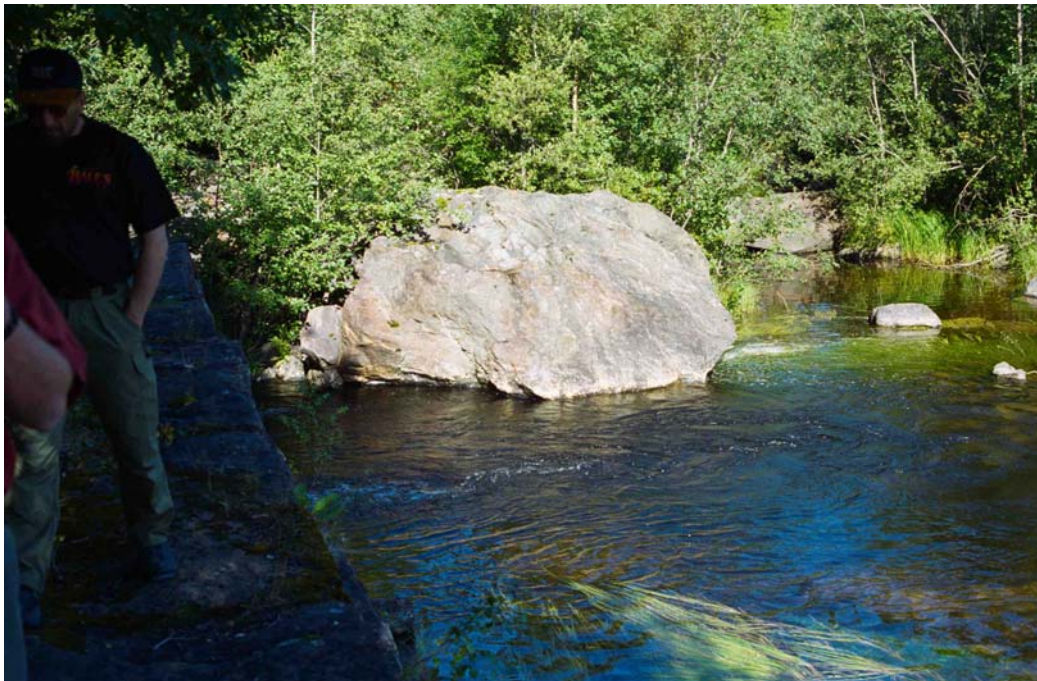
Figur 14. Öppningen i väggen på inloppskanalen strax uppströms det gamla kraftverket som skapar en alternativ väg runt Baggböleforsarna.
