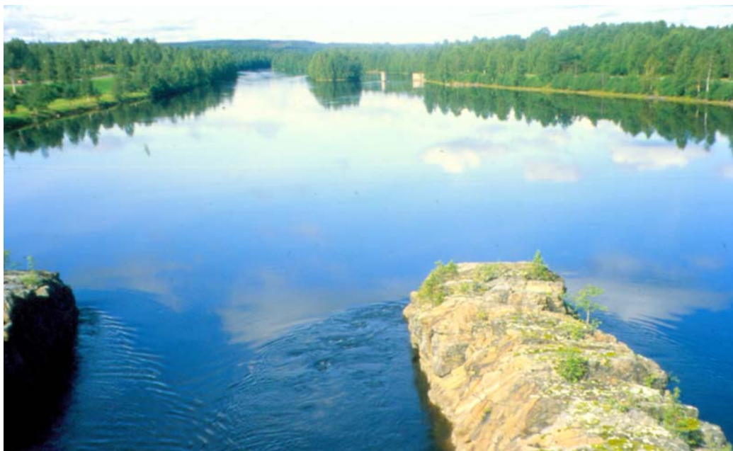
Figur 15. Inloppskanalen till Stornorrfors kraftverk där ett gallersystem för avledning av ung lax kan anläggas. Flödena mellan klipporna leder till de olika turbinerna.
